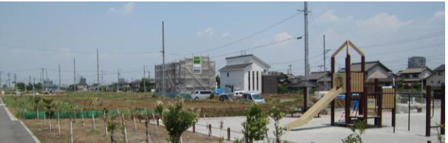
造成中の浦浜新田(上)と建設が始まった住宅区画(下)
