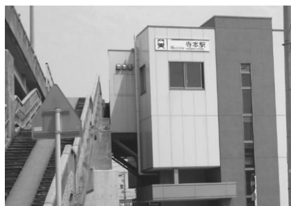
八幡の表玄関寺本駅
