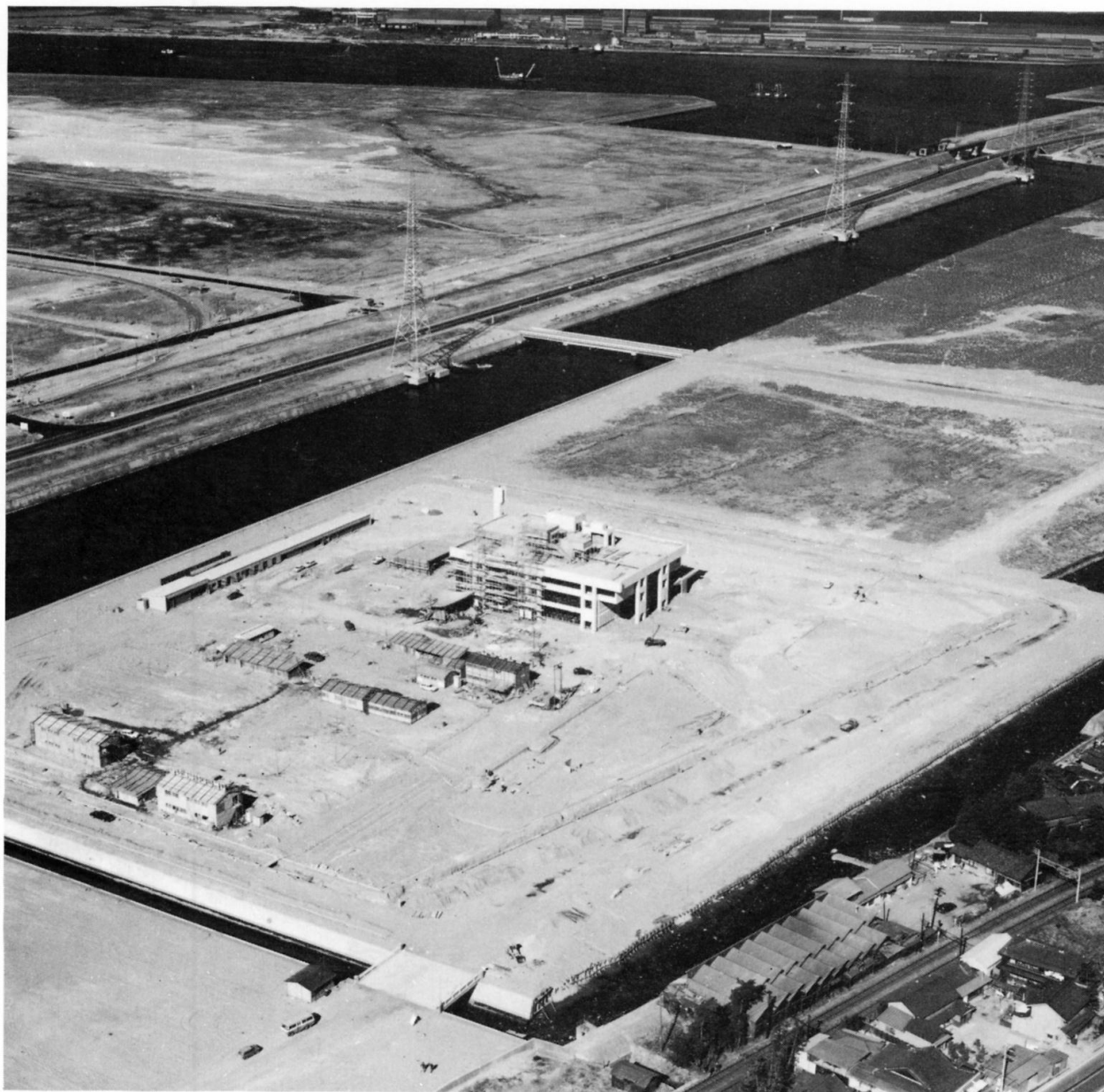
建設中の知多市役所 昭和45年9月1日、「三万人都市特令法」により、知多市が誕生した。
