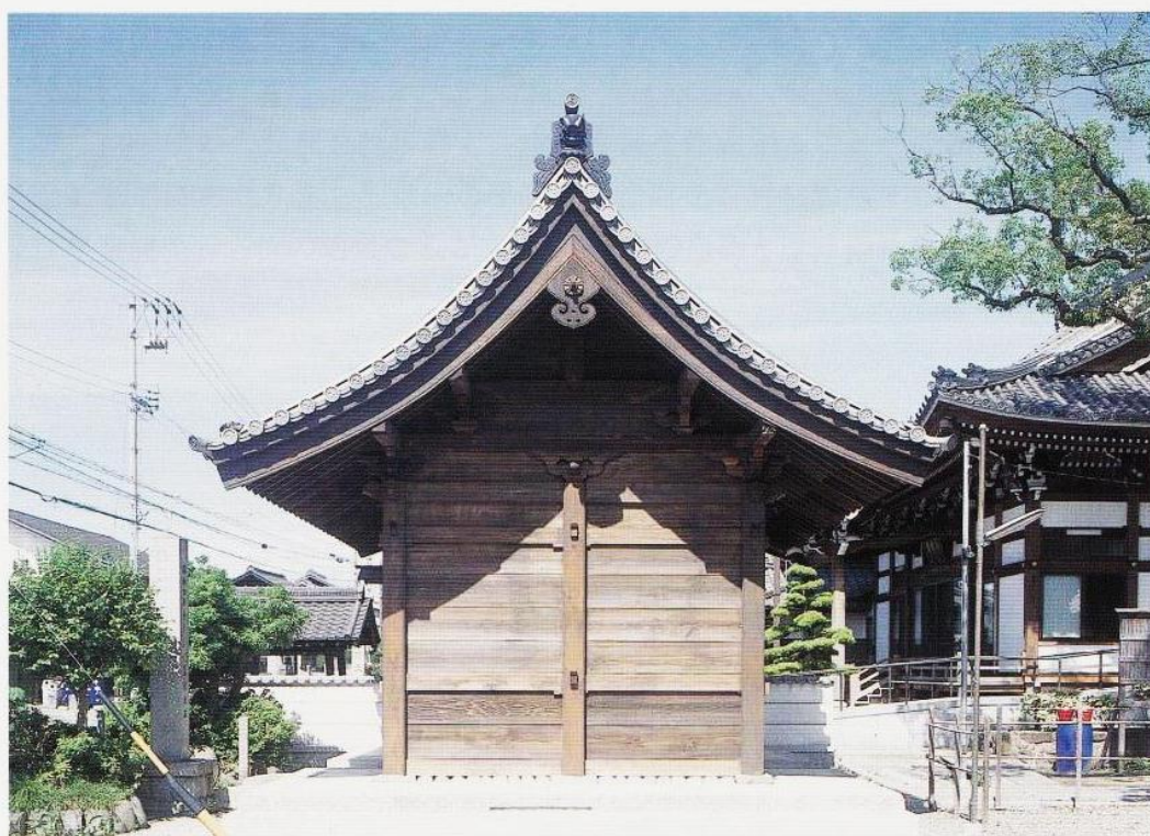
東側面（修理後）
