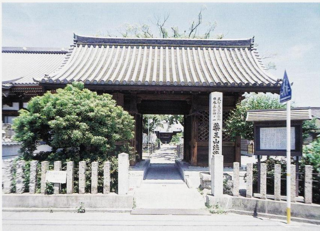
南正面外観（修理後）
