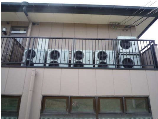
改修された側壁
