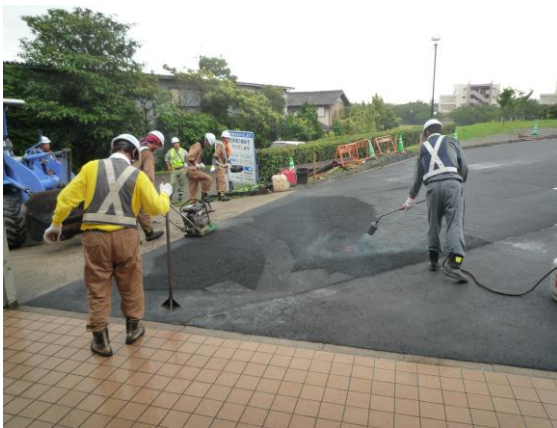
精力的に舗装工事中の作業者
