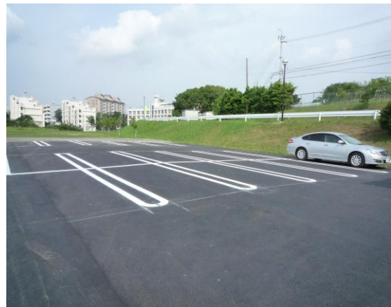
舗装が完成した駐車場
